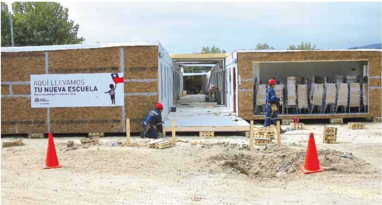
En pleno proceso de montaje de la escuela modular en Constitución.
