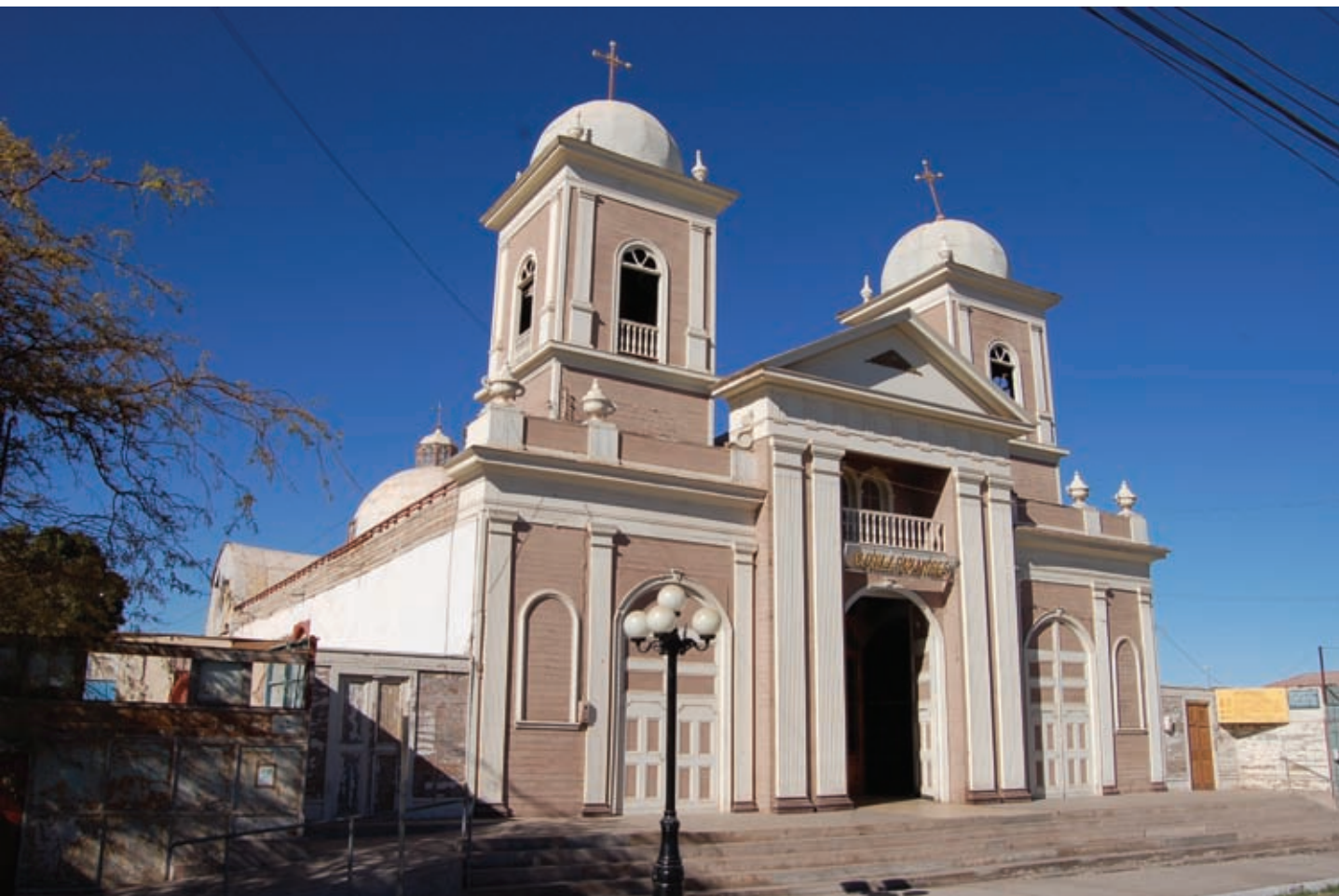
La iglesia San Andrés, Monumento Nacional, resultó con severos daños en su estructura tras el violento movimiento sísmico del 2005
