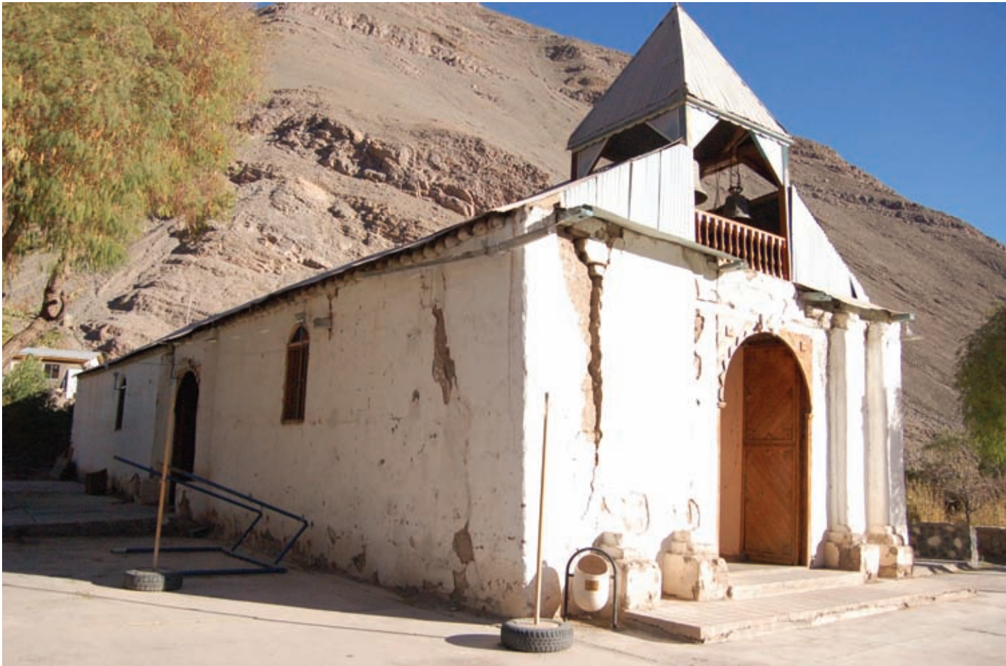
La iglesia de Huatacondo fue seriamente afectada por el violento sismo del año 2005.
