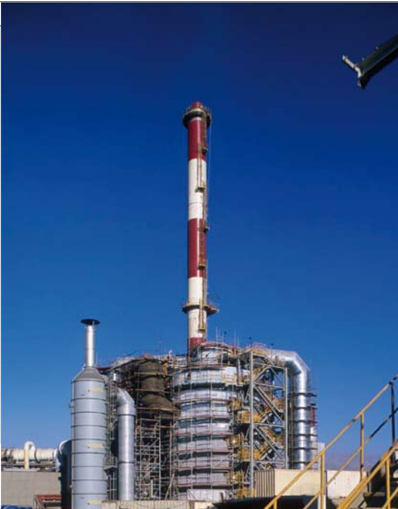
La fase 4 contempla una planta de ácido sulfúrico de doble absorción.
