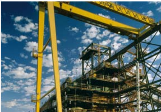
Con el apoyo de puentes grúas se realiza el mantenimiento en el Area Seca.
