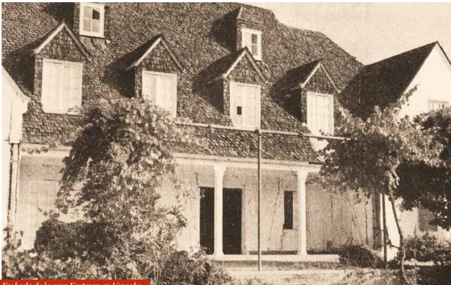
Fachada de la casa Eastman en Limache
