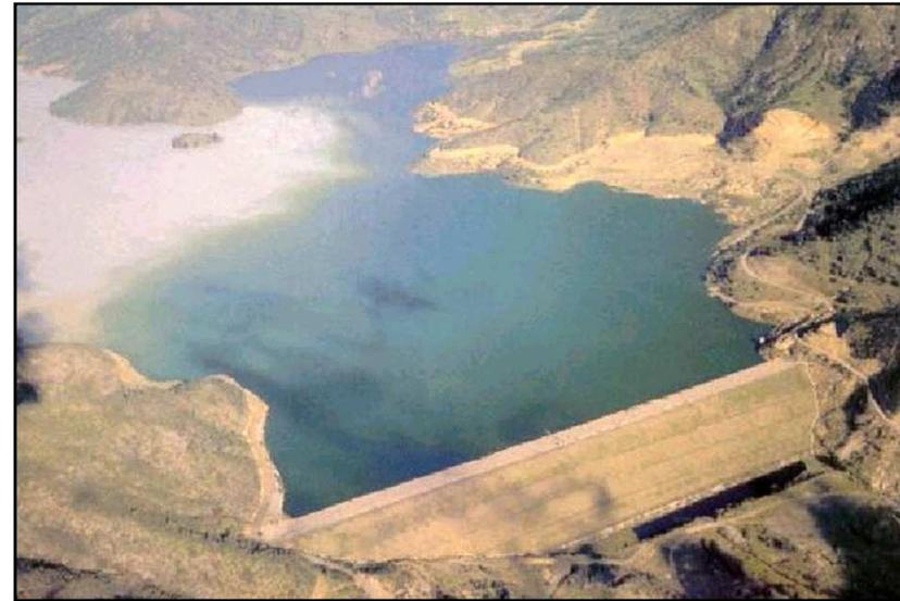
**Depósito de Relaves Tipo Tranque:** Muro de contención construido con la fracción gruesa del mismo relave.
