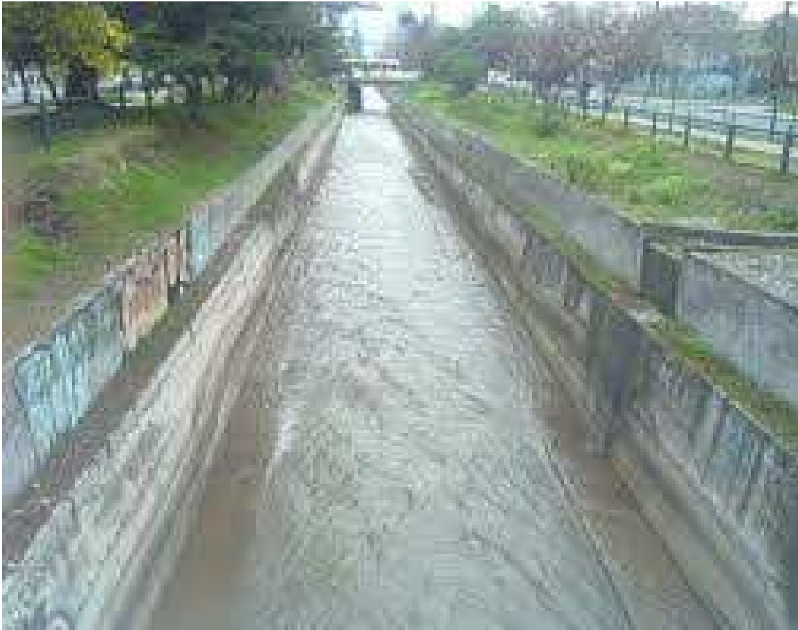
Canal San Carlos
