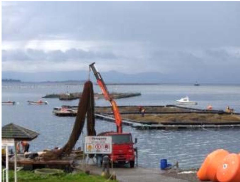
**38 toneladas de jaulas de aleación de cobre listas para ser remolcadas hasta el sitio en que serán instaladas.**
